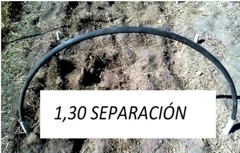
Colocación de primer arco, así de simple, la manguera negra tiene un diámetro menor a la de los tubos blancos de PVC que hacen de anclaje al suelo por eso es una estructura muy simple de hacer.
