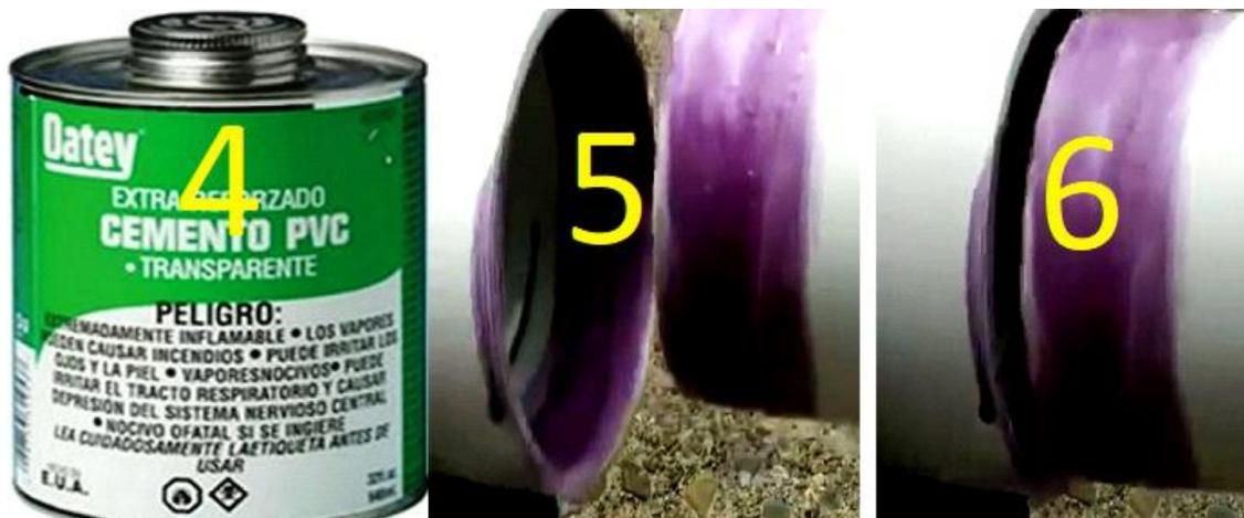
Foto 4, pegamento para PVC, los recipientes de pegamento ya traen incorporado un cepillo para untar las piezas, pasa el pegamento en el lado interno de la tapa de la foto 2, procura pasarle bastante. Fotos 5 y 6; también debes poner bastante pegamento en el lado exterior del tubo de PVC introduce el tubo a la tapa mientras giras y esperas unos segundos, no más de 10.
