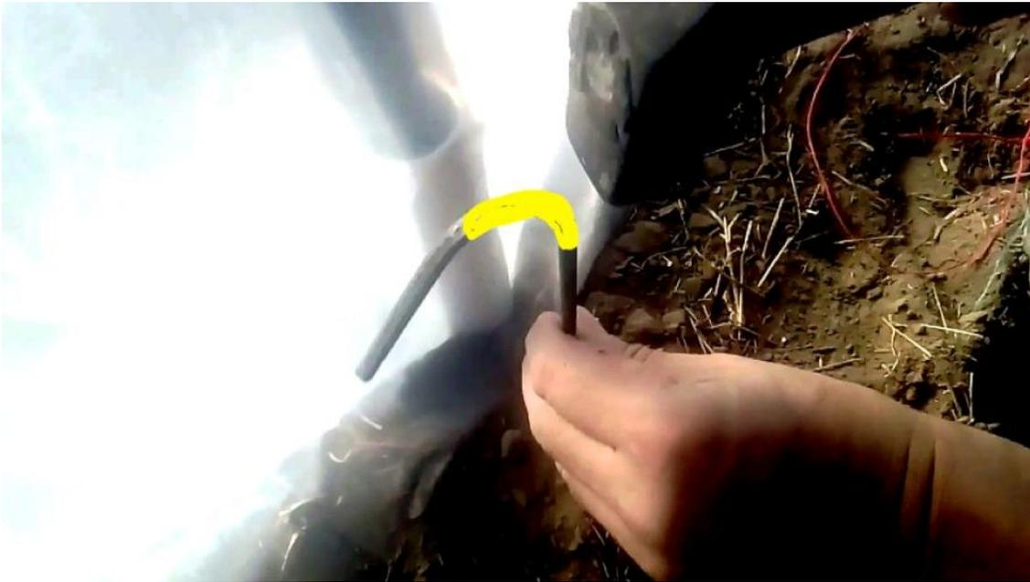
Lo que sigue es clavar un gancho de hierro al lado de cada arco en ambos lados del Microtunel, tal como se ve en la foto.
