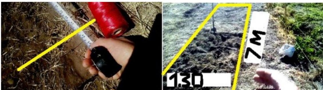
Para guiarme clavé 4 estacas de madera formando un rectángulo de 130, m de ancho por 7 metros de largo y tendí un hilo, (dibujado en
