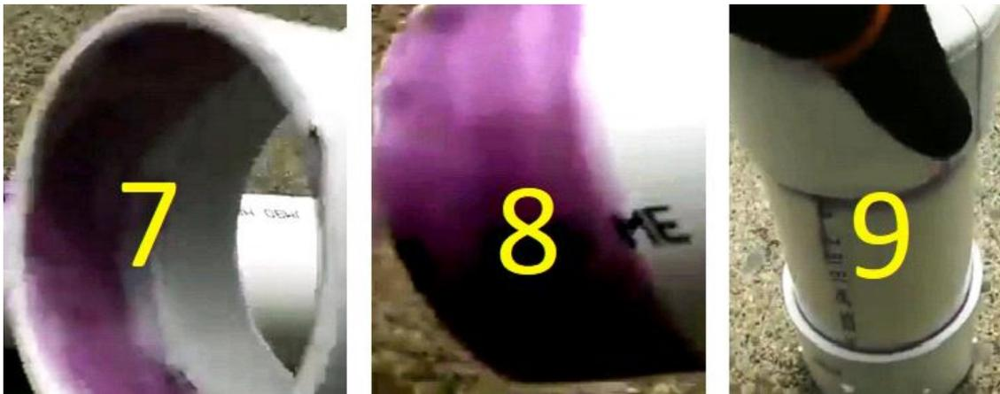
Foto 7; ponle bastante pegamento en el interior de la parte lisa o sea, que no tiene rosca en el adaptador de la tapa, foto 8; también colócale pegamento en lado exterior del tubo de PVC, foto 9; cuando introduzcas la tapa roscada al tubo recuerda girar 1/4 de vuelta y mantener unidos unos segundos.
