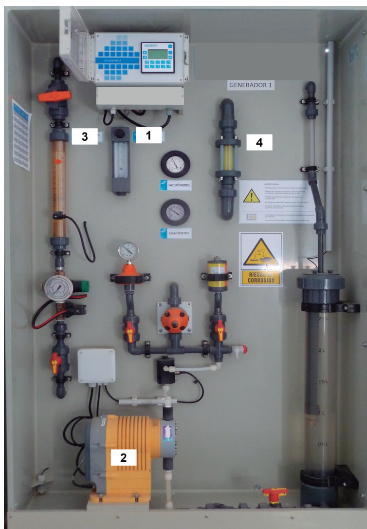
Figura 1. Generador de dióxido de cloro vía cloro gas.
